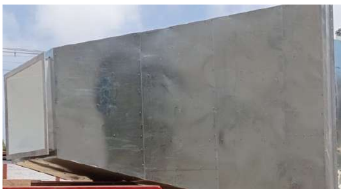
Fabricación y montaje de manifold de entrada y cajón-Bag House Fundición.
