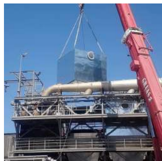
Fabricación y montaje de manifold de entrada y cajón-Bag House Fundición.
